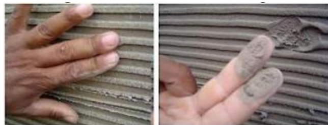
Argamassa apta para uso
