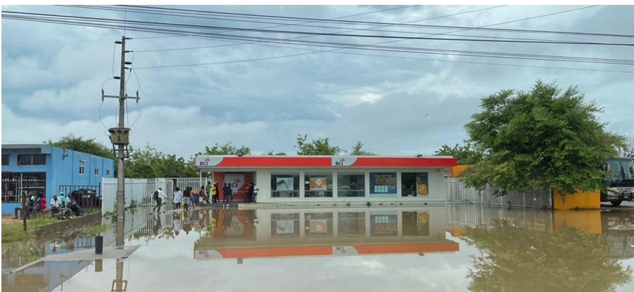
Figura 3: Estabelecimento bancário cercado de água (fonte: Portal ONU News)
