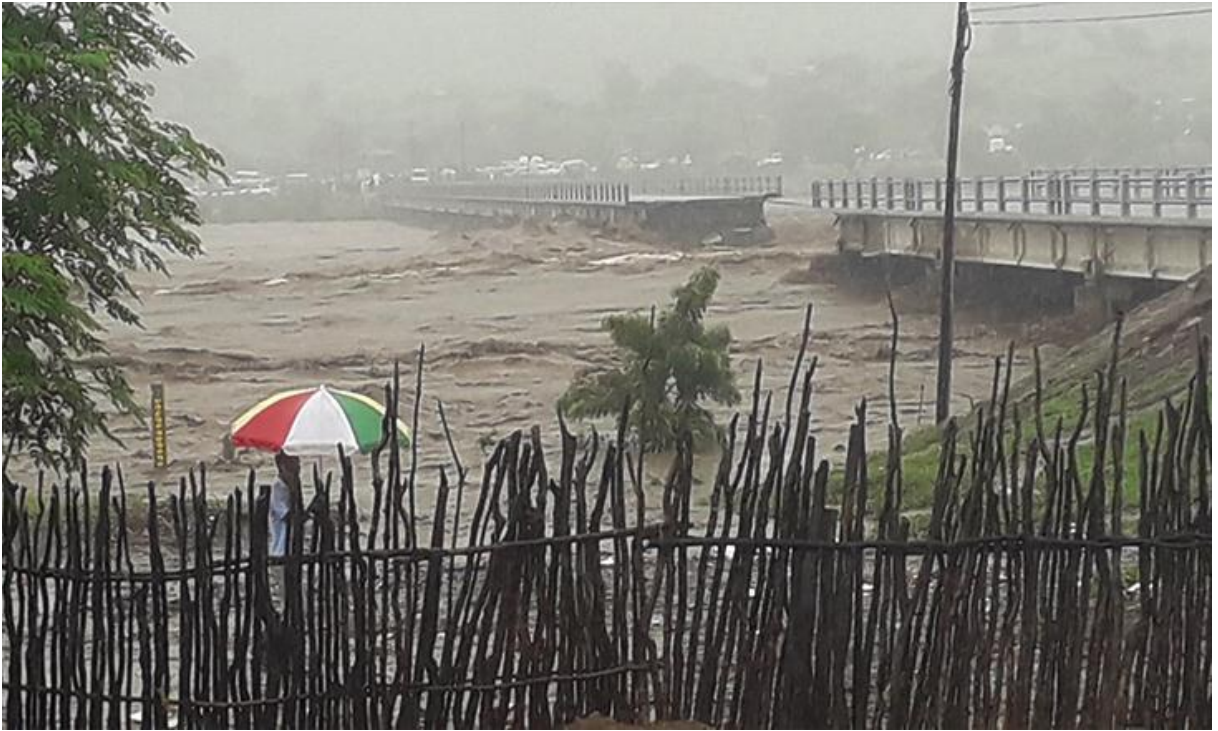
Figura 2: Ponte destruída pela tempestade Ana (Fonte: Dgedge (2022))
