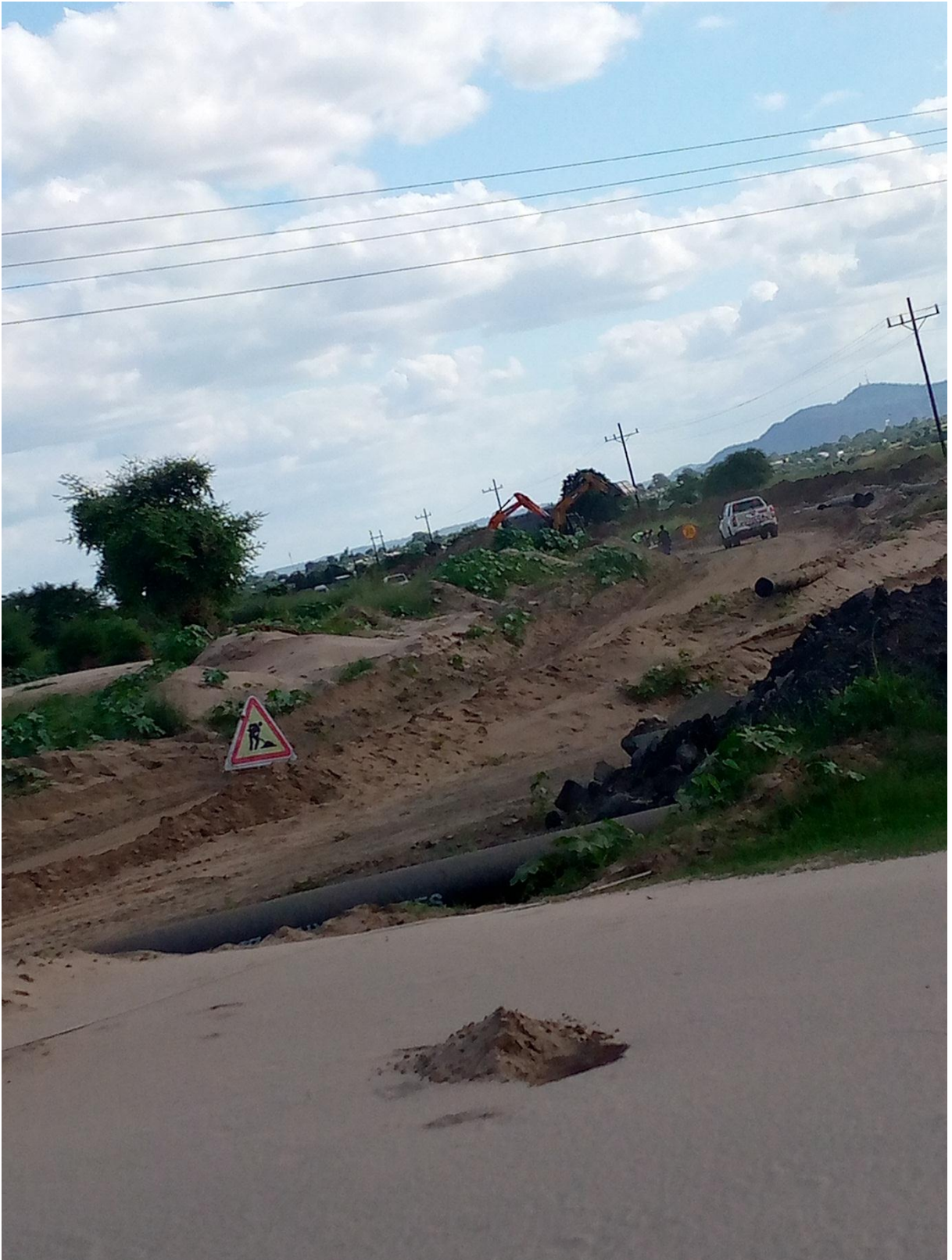
Apêndice 4: Trabalhos de reconstrução pós Ana
