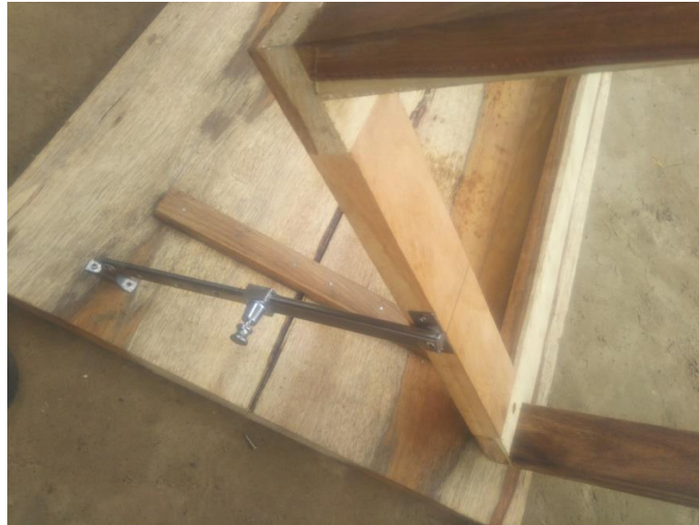
Apêndice 8: fixação do suporte do tabuleiro. Fonte: Autor, 2020
