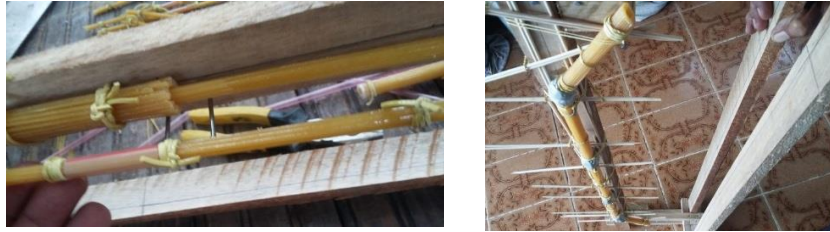
IMAGEM 6: A estrutura de madeira
