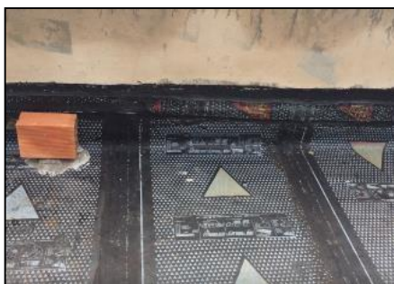
Figura 4: Aplicação da segunda camada da manta asfáltica a cima dos rodapés.
