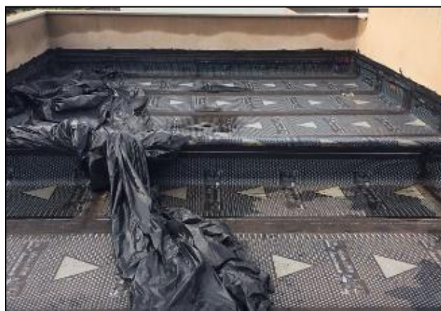
Figura 6: Aplicação do filme plástico.
