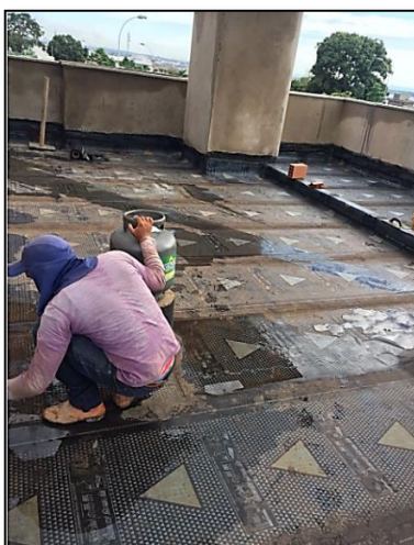
Figura 3: Aplicação da manta asfáltica
