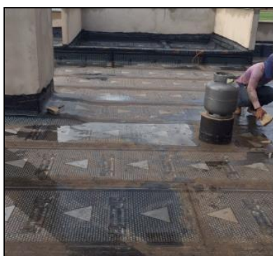
Figura 5: Utilização do maçarico
