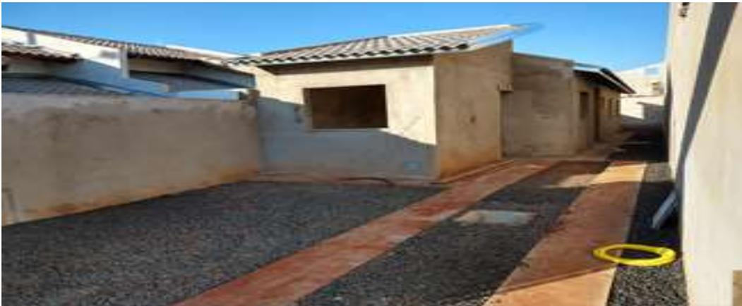
**Figura 5 - Edificações com paredes de concreto já rebocadas**
