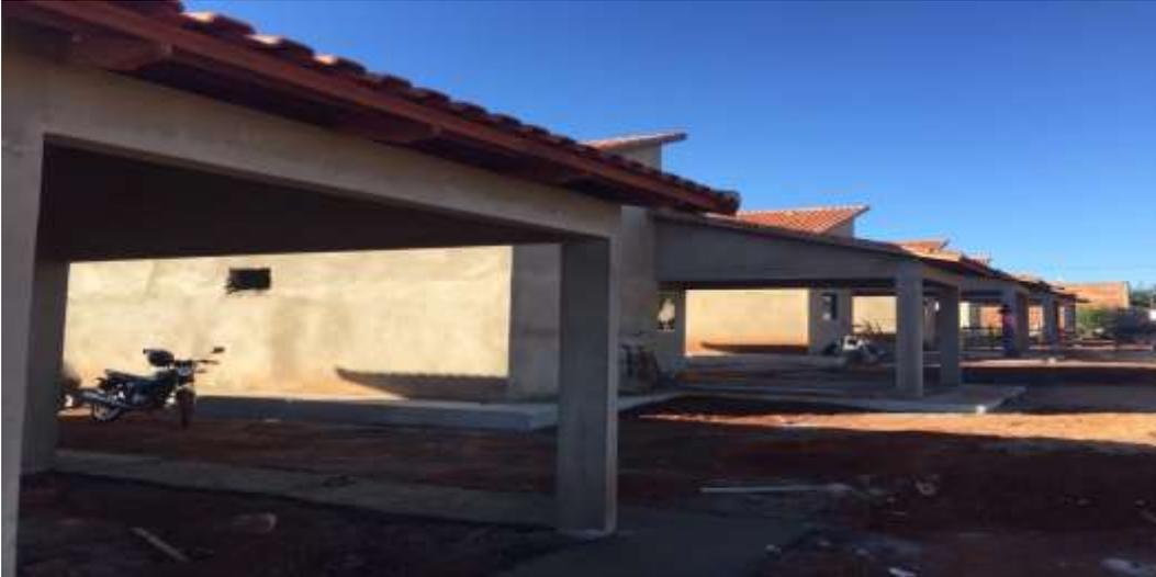
**Figura 6 - Edificações com paredes de tijolos cerâmicos já rebocadas**
