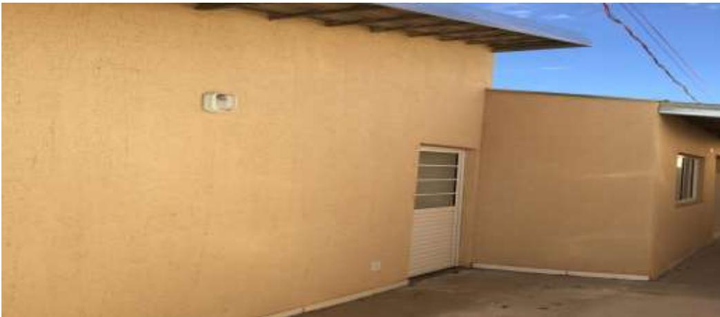
**Figura 17 - Casas de paredes de concreto**
