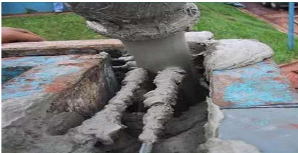
**Figura 11 - Introdução do concreto nas fôrmas**
