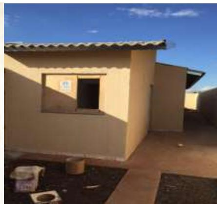
**Figura 13.2 - Parede de concreto já com pintura**
