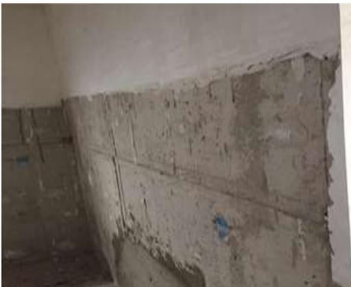
**Figura 13.1 - Reboco aplicado sobre a parede de concreto**
