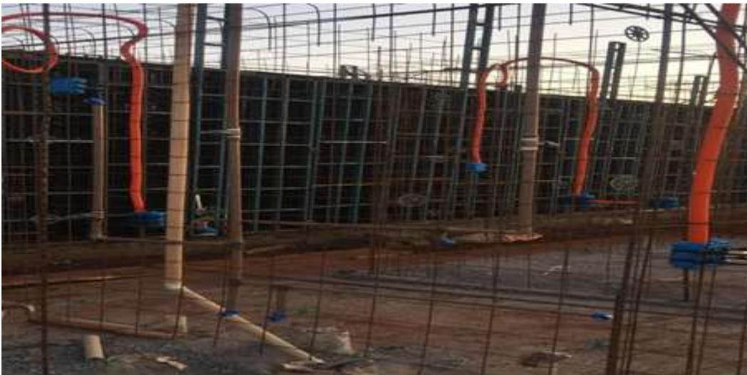
**Figura 8 - Treliças montadas, conduítes e caixas de passagem das instalações elétricas**
