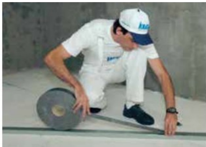
Figura 8 – Instalação da fita isolante acústica
