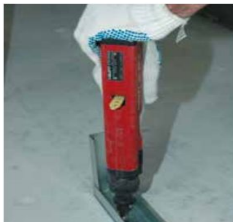
Figura 9 – Fixação dos parafusos
