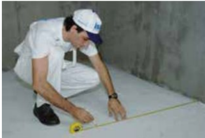
Figura 7 – Locação da Parede
