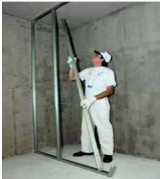
Figura 10 – Instalação dos montantes.
