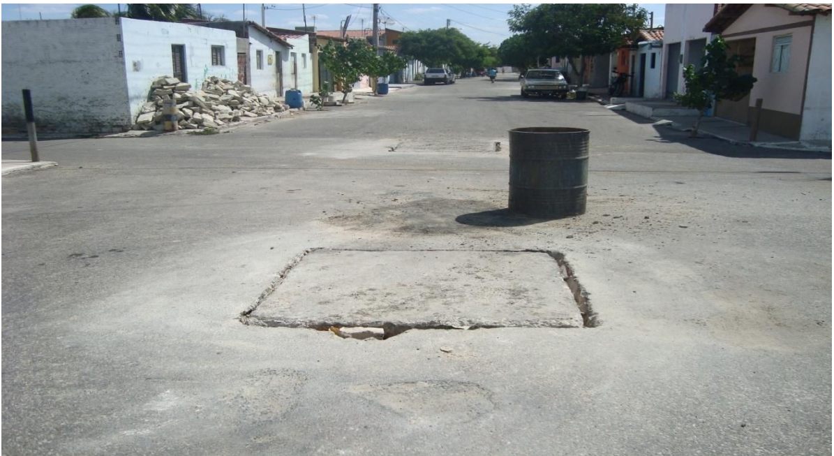
Figura 3 Caixas de esgoto obstruídas na Rua Miassaba.
