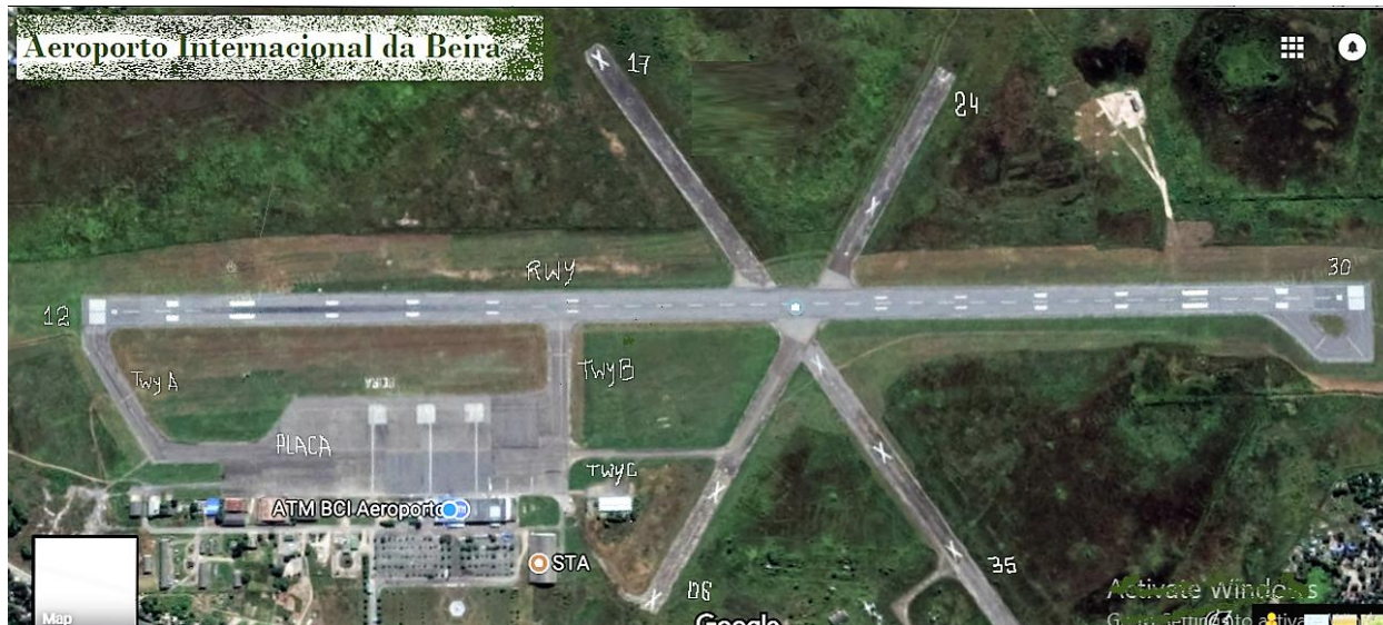
Fig. 3 Vista aérea do Aeroporto Internacional da Beira
