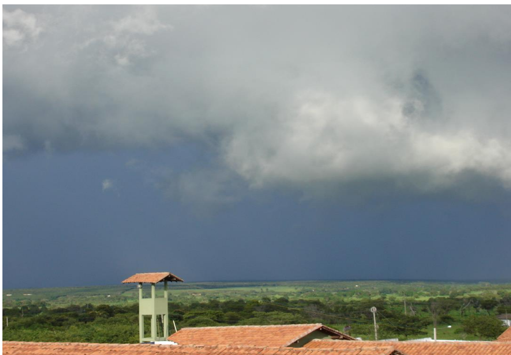
Figura 13 - VISÃO DE CIMA DOS PAVILHÕES DA PENITENCIÁRIAREGIONAL DE BOM JESUS
