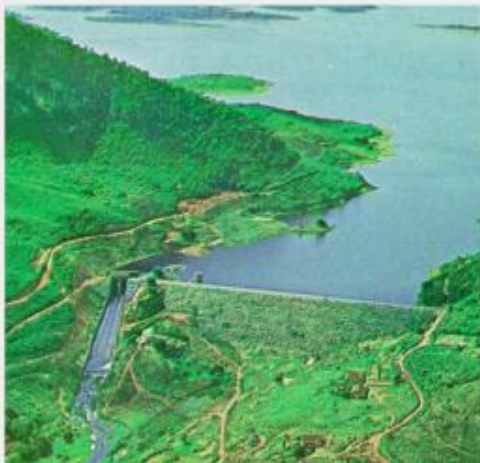
Barragem de terra.
