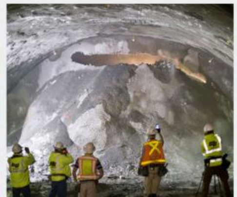
Escavação para construção de túnel
