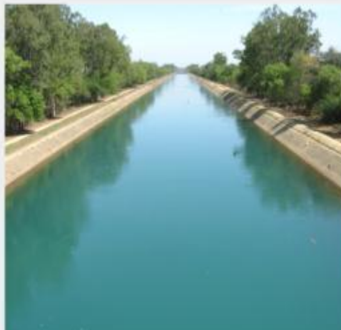
Canal com revestimento de concreto.
