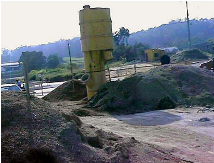
Figura 14 – Execução de tubulão ar comprimido.
