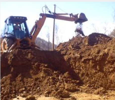
Espalhamento de material para aterro
