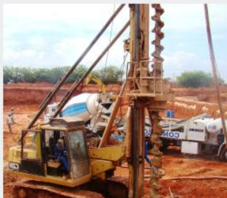
Perfuração de solo para concretagem de estaca
