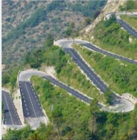
Estrada construída em região de alto aclave / declive
