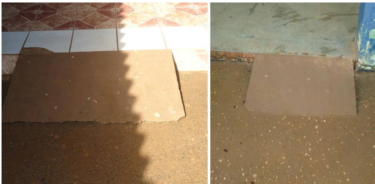
Figura 2: Rampa de acesso _ Refeitório e corredores
