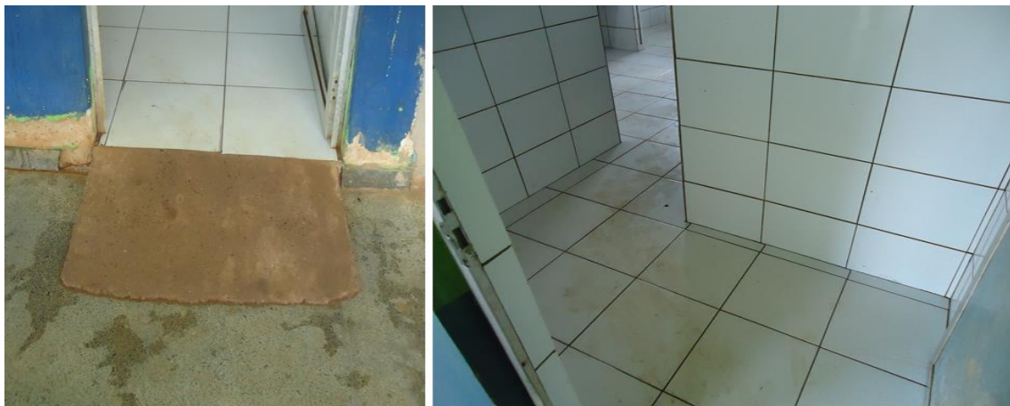
Figura 7: Rampa de acesso para o sanitário
