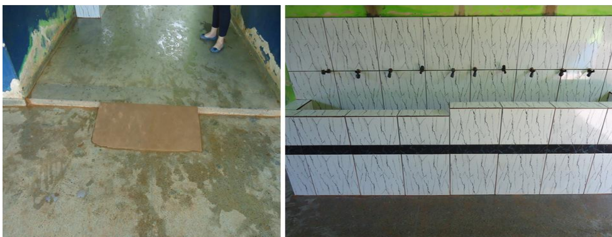
Figura 5: Rampa de acesso para o bebedouro e bebedouro
