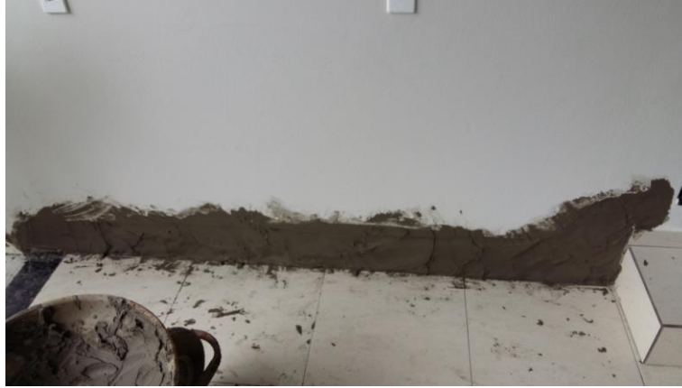
Figura 9: Aplicação do novo reboco na parede com argamassa AC-III. FONTE: O autor (2016).
