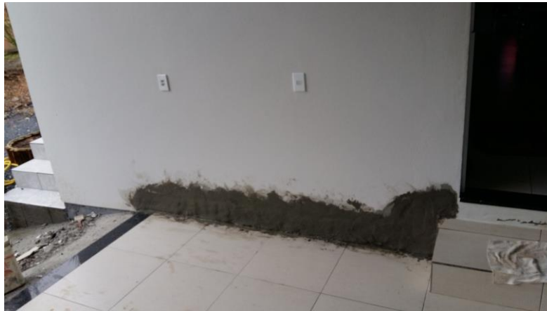
Figura 10: Parede com novo reboco finalizado. FONTE: O autor (2016).
