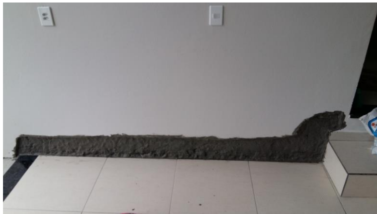
Figura 8: Aplicação do impermeabilizante na parede da edificação.
