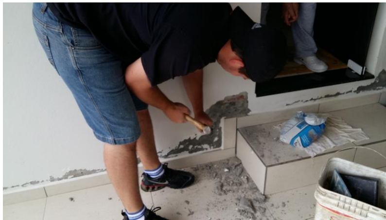
Figura 5: Parede da edificação sendo retirado o reboco.
