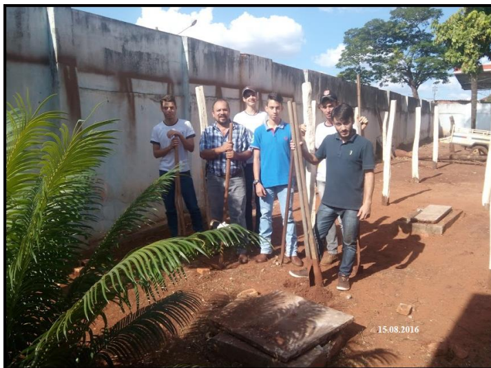
Figura 01: Preparação do terreno e implantação dos postes em área do Colégio Estadual Independência – Quirinópolis, 15 de agosto de 2016.
