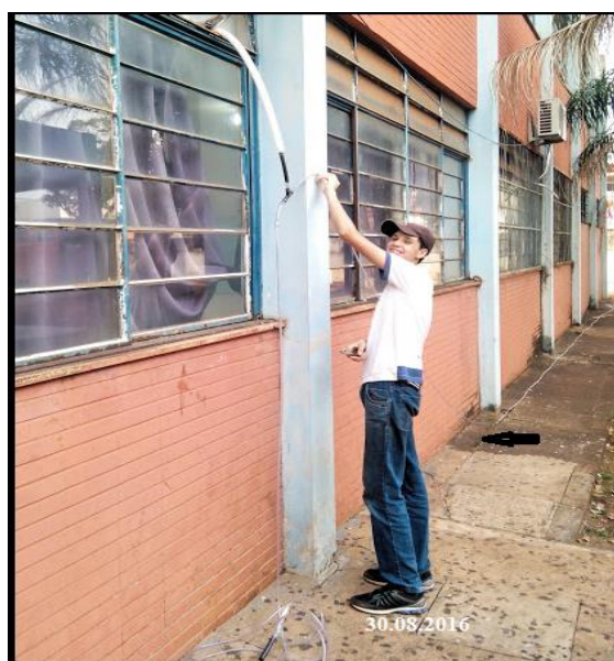
Figura 11: Aluno Ibraim, instalando o sistema coletor de água dos condicionadores de ar - agosto de 2016.
