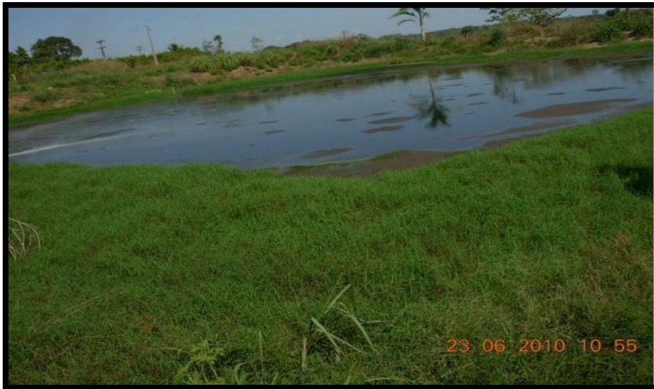
Figura 06: 3ª lagoa de decantação.
