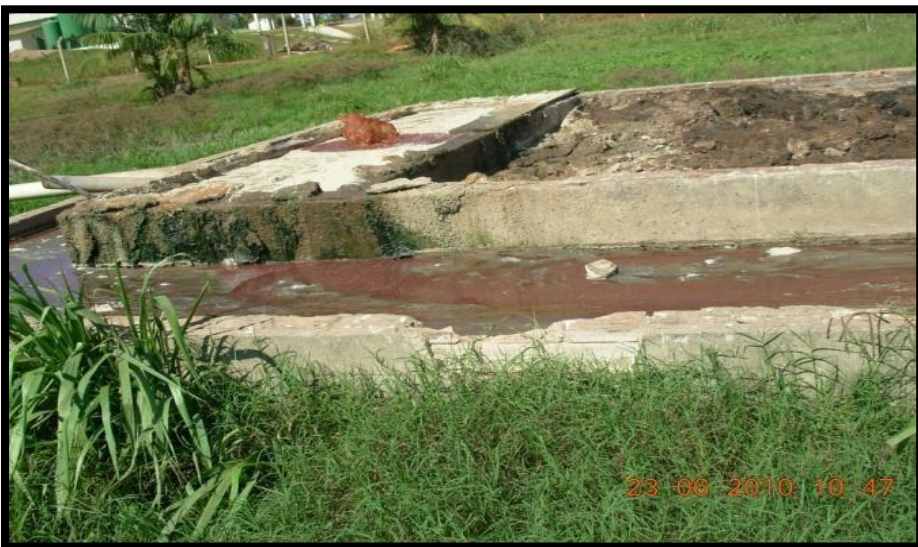
Figura 02: Carreamento de efluente para a 1ª lagoa (decantação).
