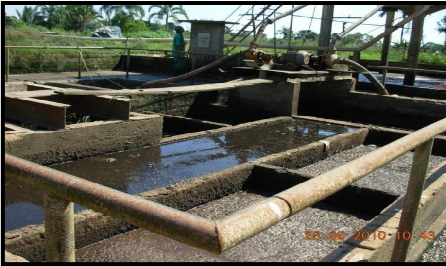
Figura 03: Estação de tratamento primário.
