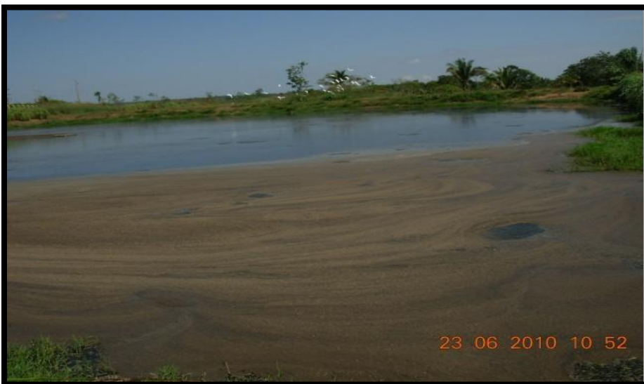
Figura 05: 2ª lagoa de decantação.
