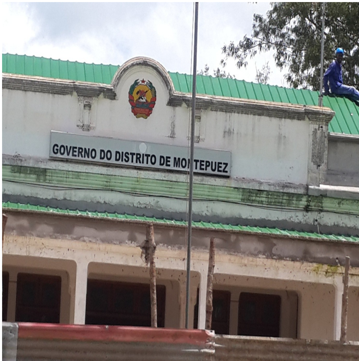
Imagem3: A imagem representa as instalações do Governo Distrital de Montepuez
