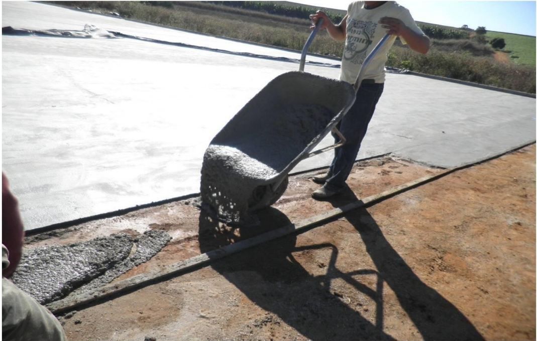
Figura 1- fase de construção do terreiro de lama de cimento com 1,5 cm de espessura.
