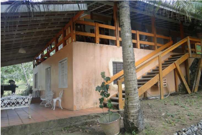
Foto 07 - Vista Lateral Direita - Sobrado
