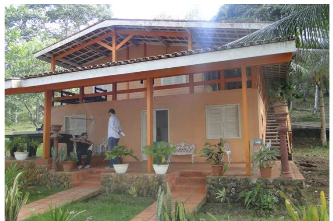
Foto 06 - Vista Frontal – Sobrado
