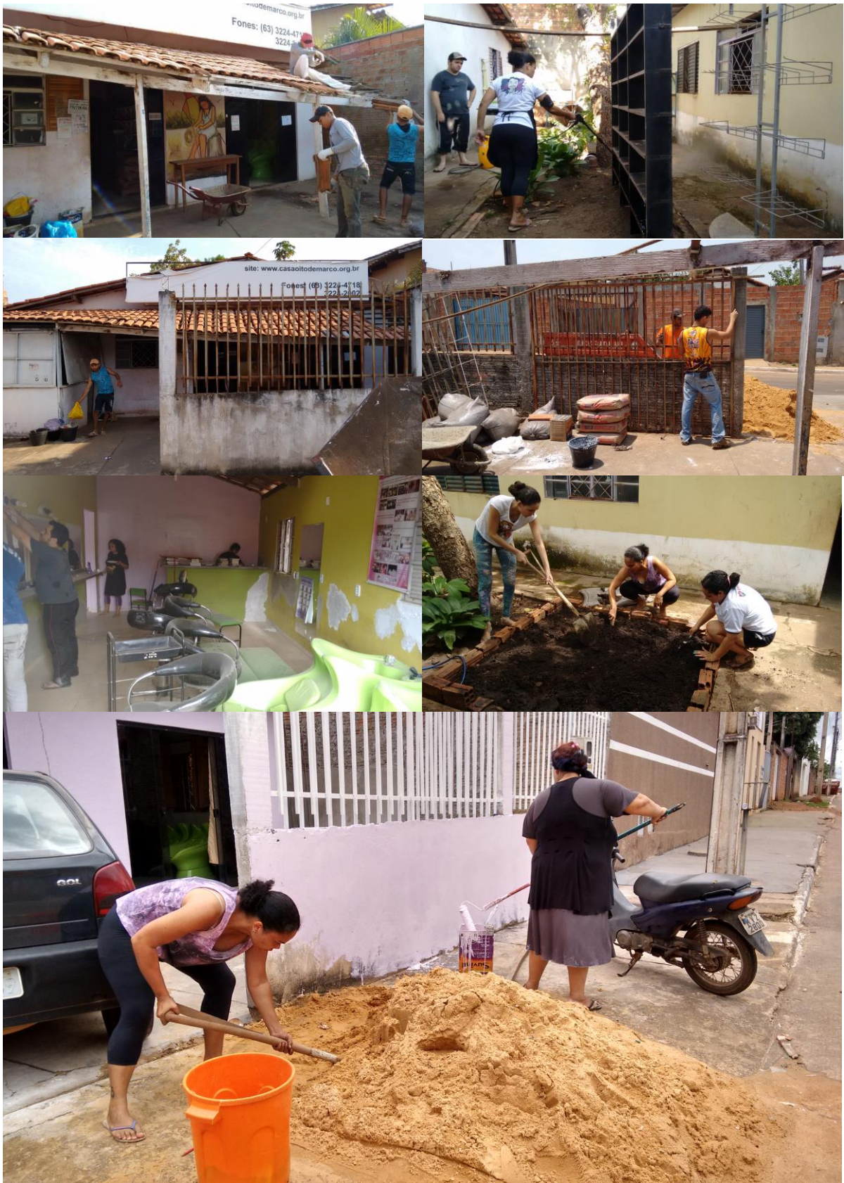
Figura 2 - Revitalização da Casa 8 de Março
