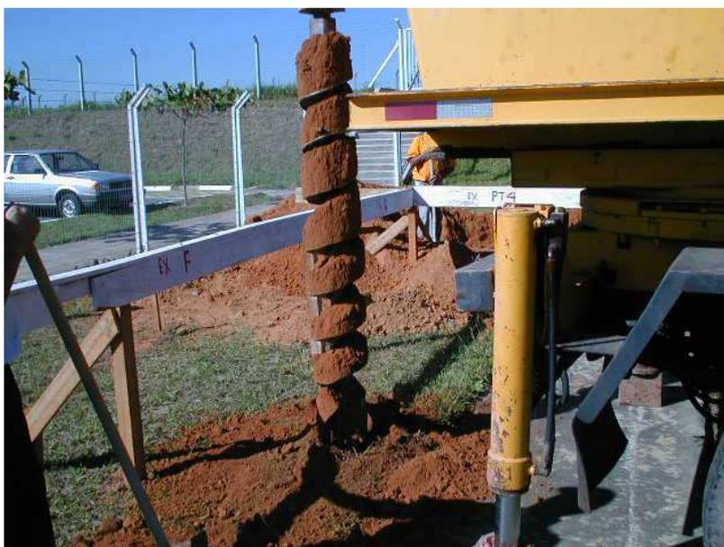
**Figura 2.4: Retirada de material no trado helicoidal mecânico.**
