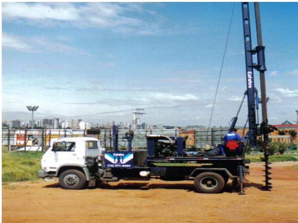
**Figura 2.1: Execução de estaca por trado helicoidal através de torres metálicas, acopladas em caminhões.**
