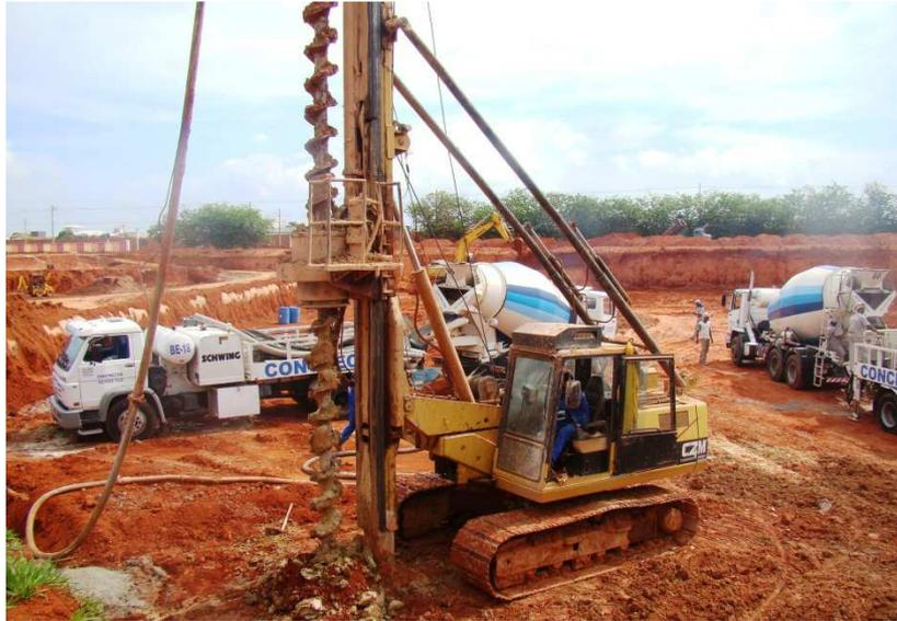
**Figura 3.1: Máquina equipada com trado-helicoidal contínuo (hélice contínua).**
