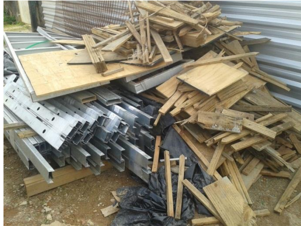
Figura 4 – Material em estocado de maneira errada.
