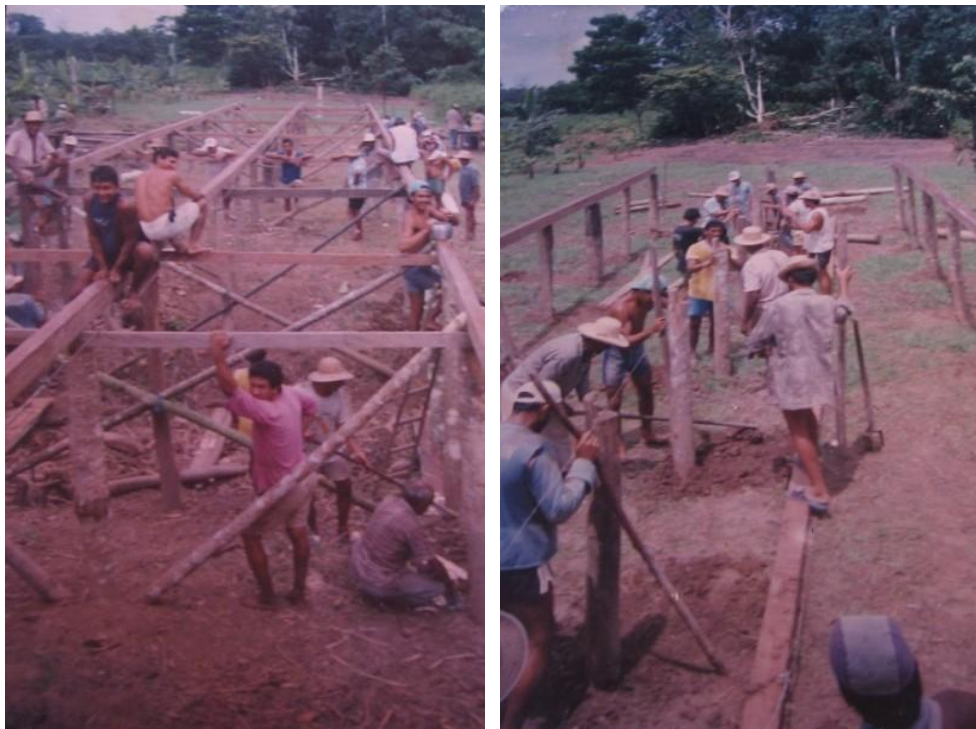
Figura 05 - Estrutura de madeira sendo fixada para passagem da casa. Fonte: Arquivo da família Souza reproduzido por Cleusa Mello, 2010.
