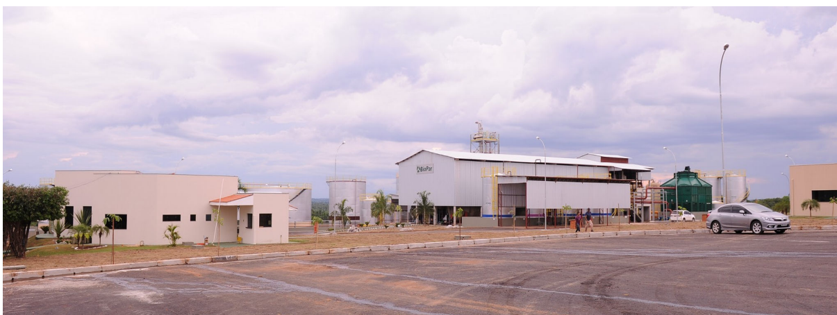
Fotografia 03 – Nova fabrica de Biodiesel, vista interna do pátio.
