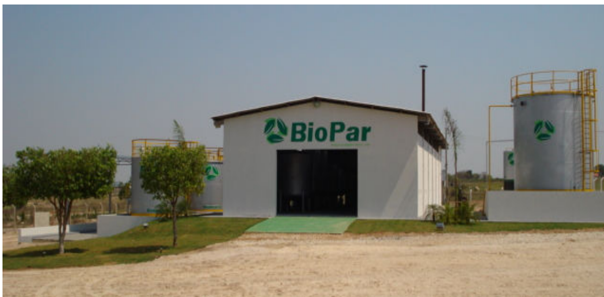
Fotografia 01 - Antiga fabrica de Biodiesel, vista externa.
