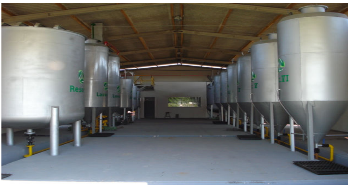
Fotografia 02 – Antiga fábrica de Biodiesel, vista interna.
