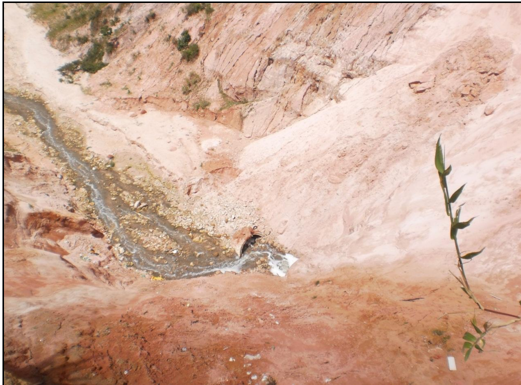
Figura 10: Tubulação rompida pela forte pressão das águas do Tabuleiro do Martins.
