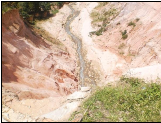
Figura 8: Saída da Macrodrenagem do Tabuleiro do Martins
