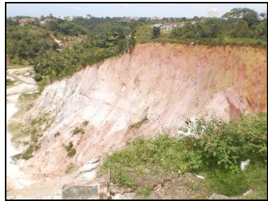
Figura 9: Erosão do Tipo Voçoroca na saída da macrodrenagem
