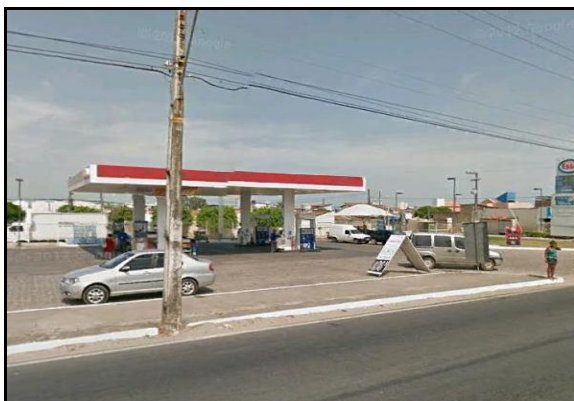
Figura 14: Posto de Abastecimento na Serraria
