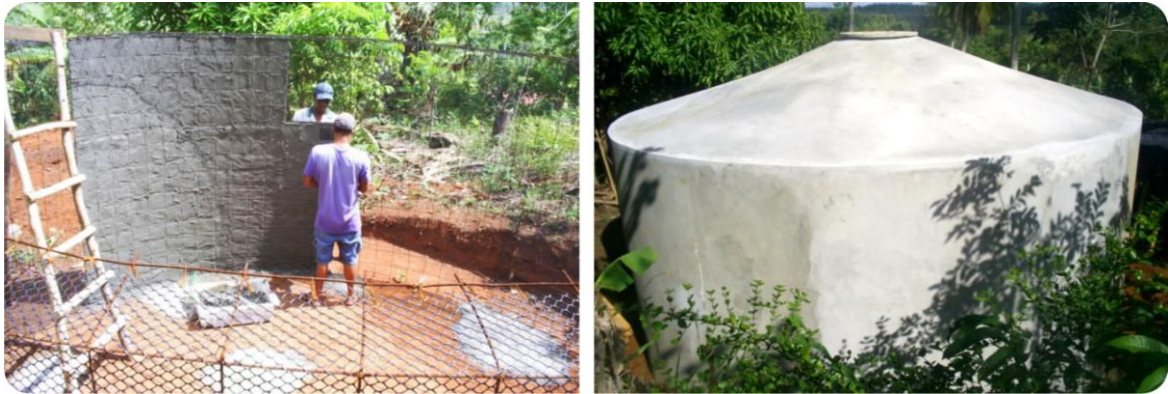
Figura 34 - Cisterna em construção e em processo de finalização.
