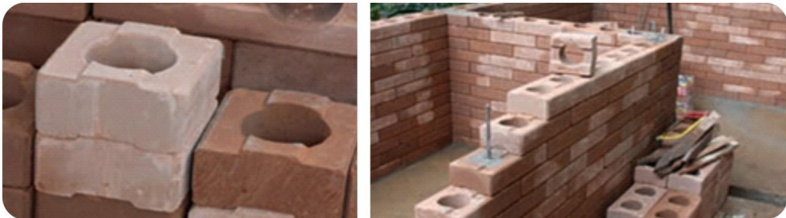
Figura 14 - Modelo de tijolo em solocimento.
