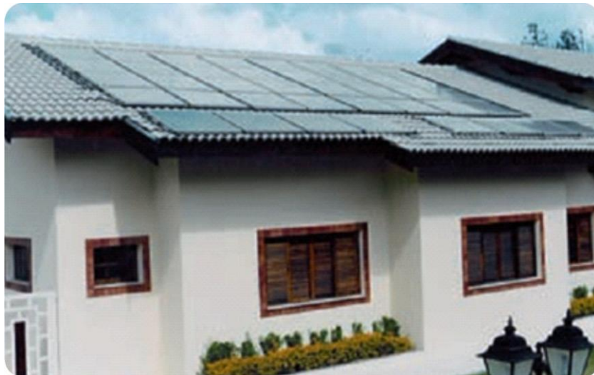
Figura 30 - Residência com sistema de coletores solares.
