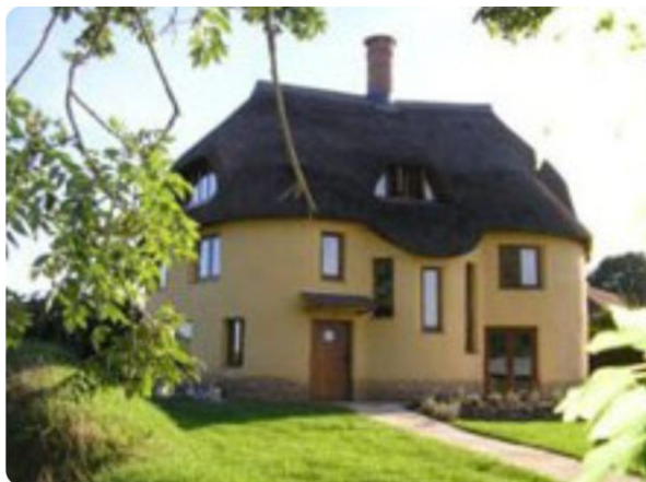
Figura 13 - Casa com 3 pavimentos em cob.
