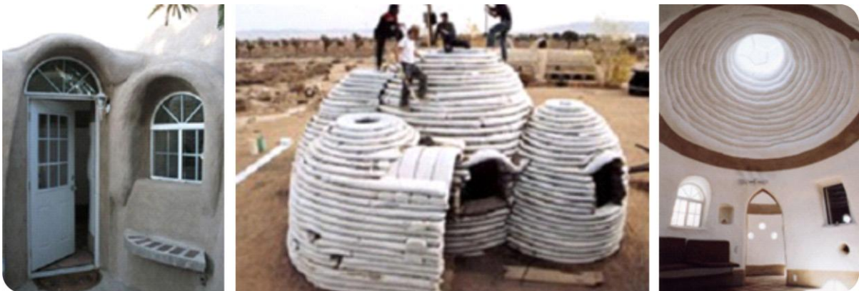
Figura 12 – Outras construções a partir da técnica de superadobe
