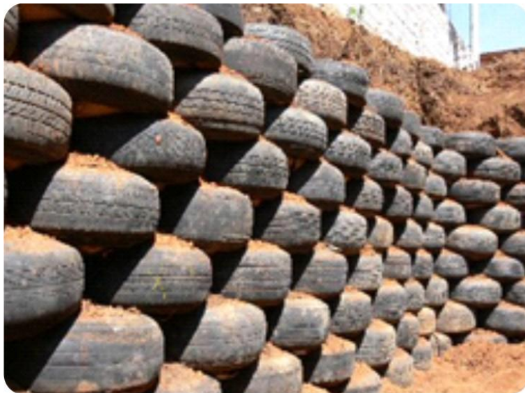
Figura 19 - Parede de pneus 14
