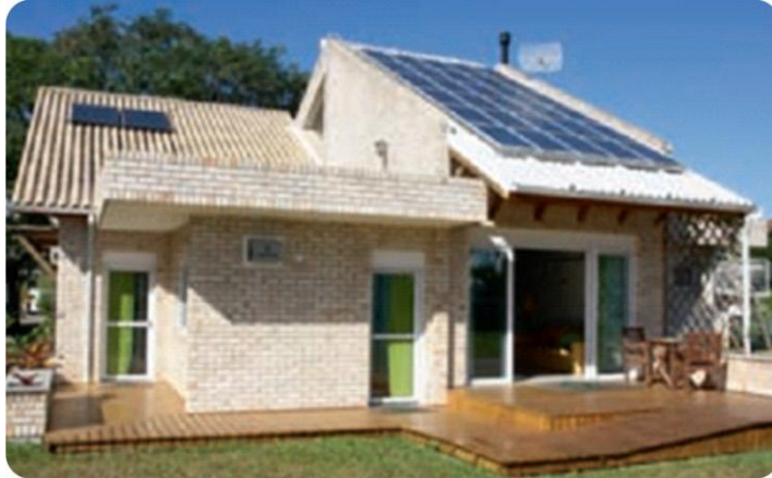
Figura 28 - Residência com placas fotovoltaicas.
