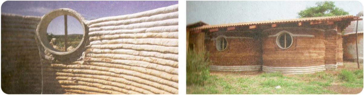
Figura 11 - Construções a partir da técnica de superadobe
