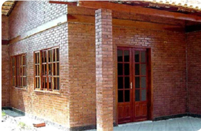
Figura 15 - Casa construída utilizando técnicas de solocimento 11
