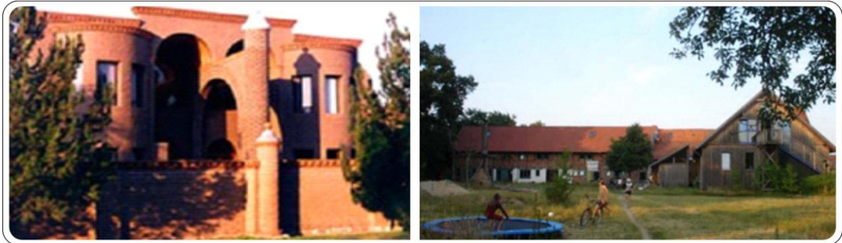
Figura 10 - Construções a partir de tijolos adobe 10
